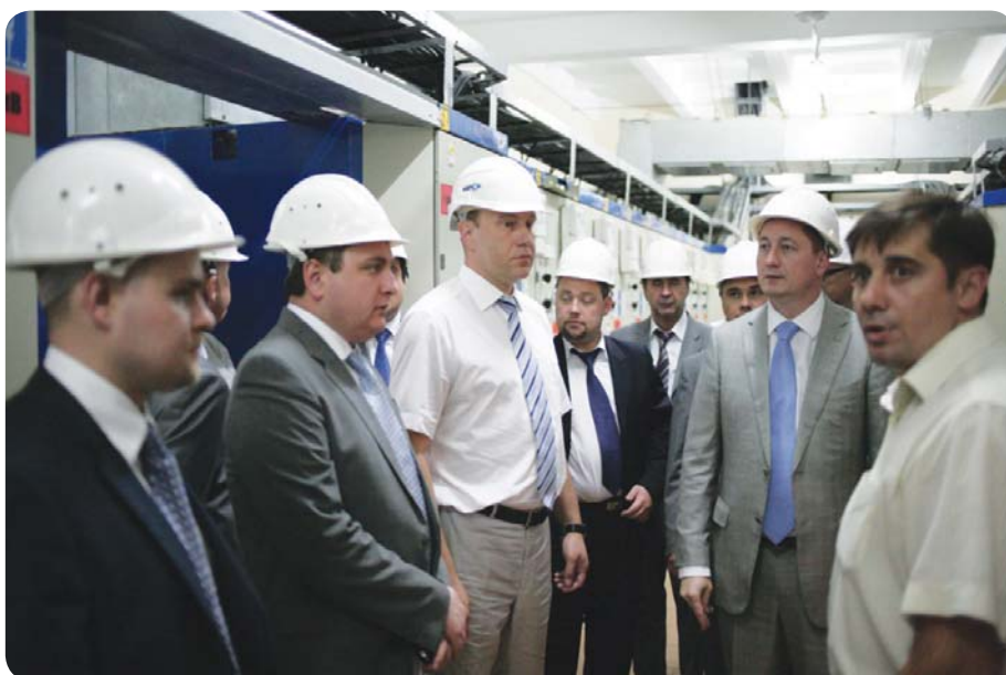
На подстанции 110 кВ «Центральная» (г. Ростов-на-Дону)
