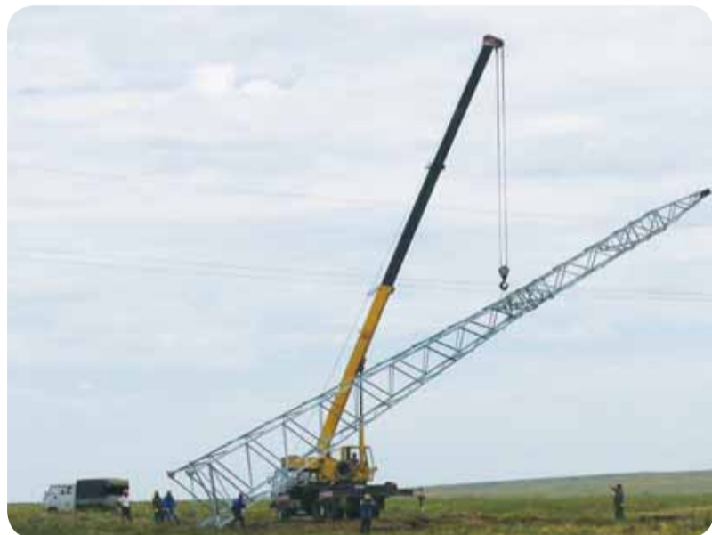
Установка последней опоры ВЛ «Вышестеблиевская-220 - Волна»
