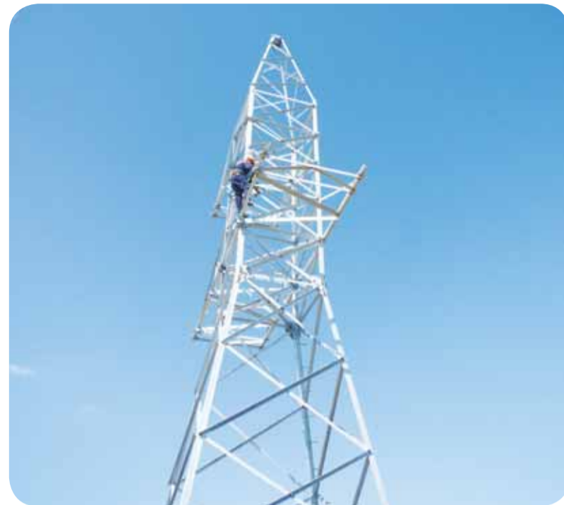
Подготовка опоры к эксплуатации
