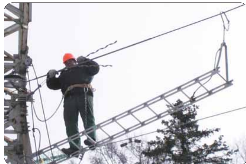
Монтаж спиральной арматуры на воздушной линии
