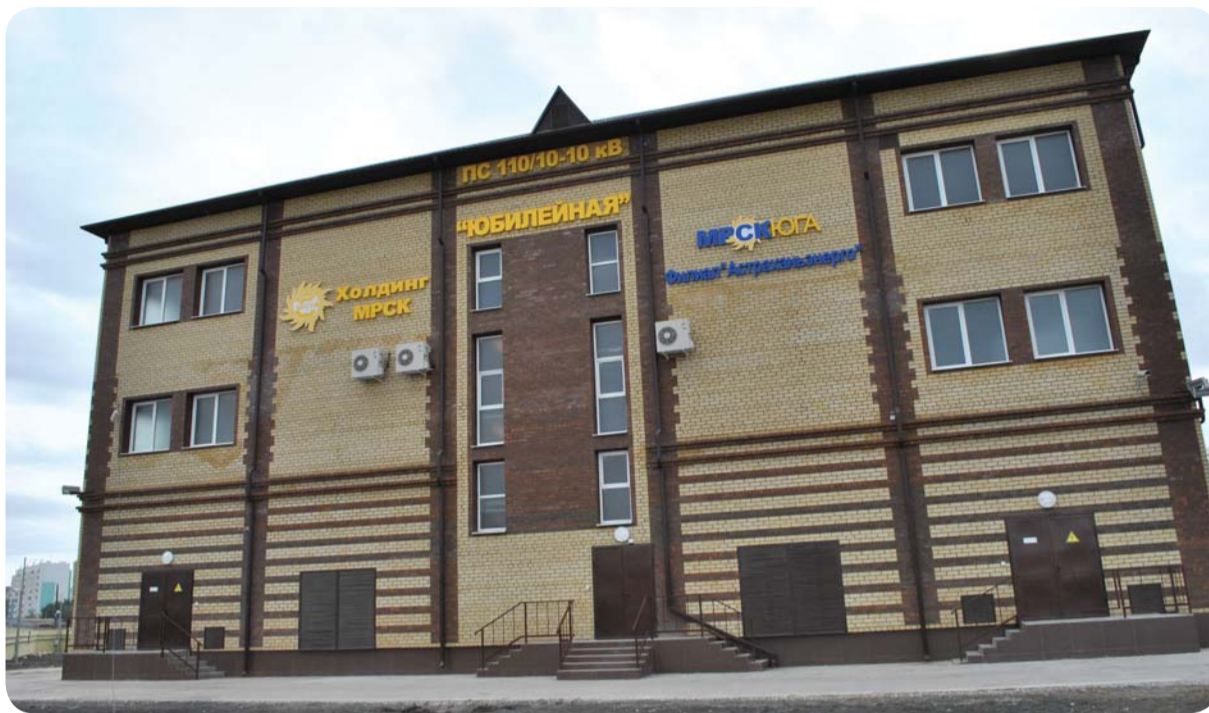
Открытие астраханской подстанции «Юбилейная» стало одним из важнейших событий года в жизни Компании
