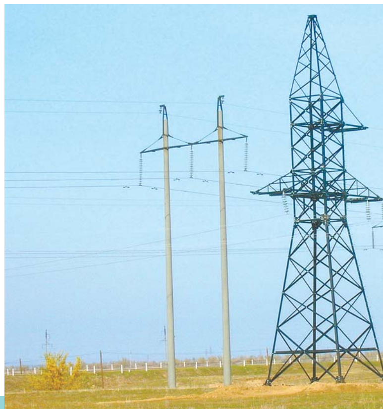
Быковский район Волгоградской области. Линия 110 кВ «Танино-Головная» филиала ОАО «Волгоградэнерго» «Левобережные электрические сети» - системообразующая для всего Заволжского региона области: до (слева) и после реконструкции. Замена линии позволила создать резерв надежности, обеспечить подключение кольцевых линий.
