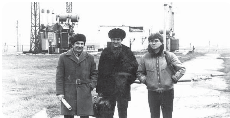
Инженер службы релейной защиты Сергей Осадчий (в центре) с коллегами на ПС «Элиста Северная». 1983 г.
