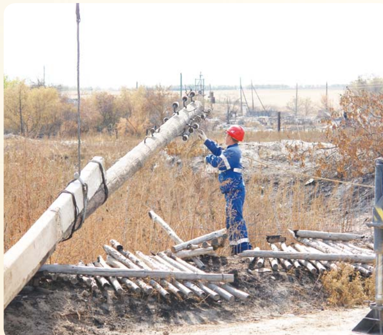
Волгоградские энергетики восстанавливают линии электропередачи после ландшафтного пожара. Сентябрь.
