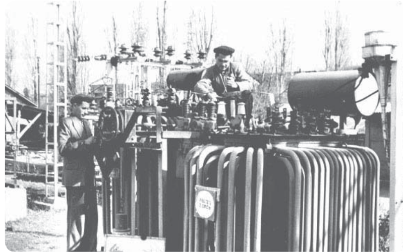
Монтаж компенсационной катушки на подстанции «Сочи». 50-е года 20 века
